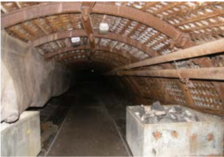
Galeries de mine avec étaitements métalliques
