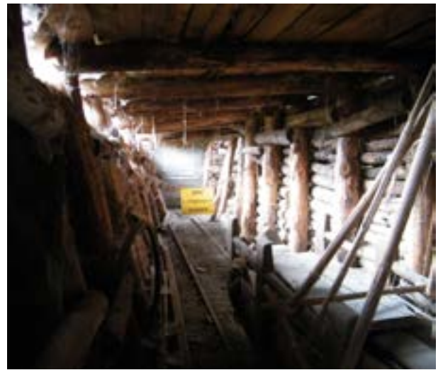
Galeries de mine avec étaitements en sapin
