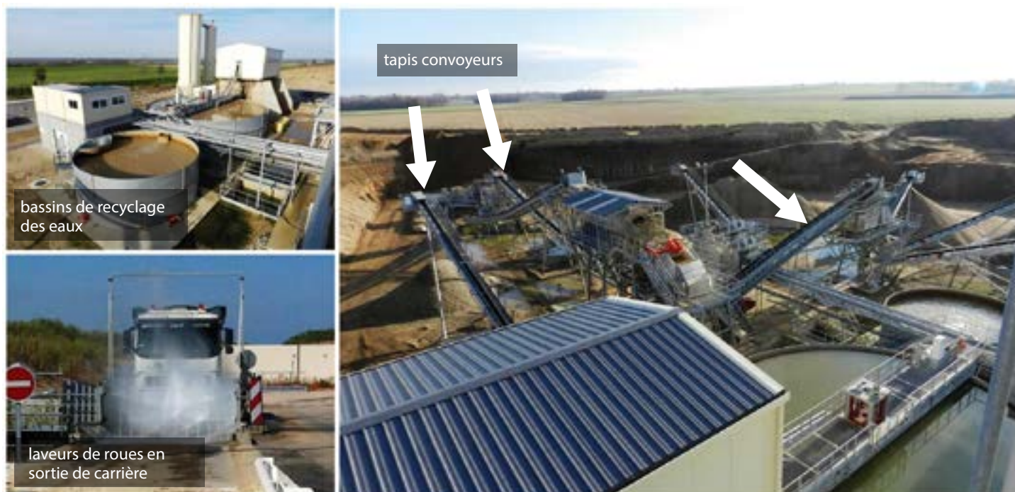
Sablière à Saint-Loup
